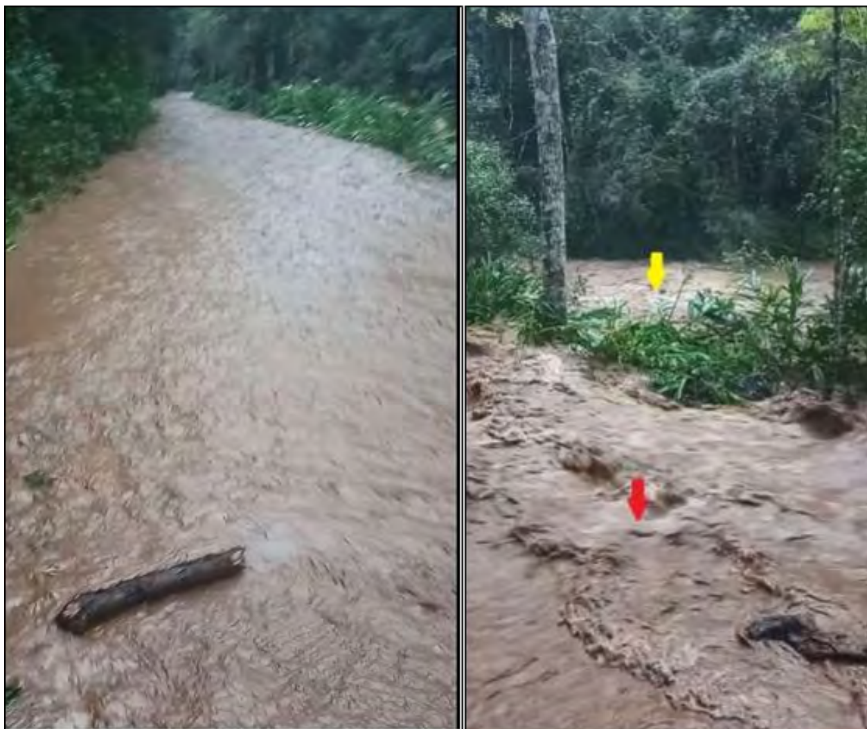
Figura 3.. Estrada sendo parcialmente tomada pela água. Seta amarela calha do arroio. Seta vermelha margem da estrada. Imagem de 30/04/24 15:26.
