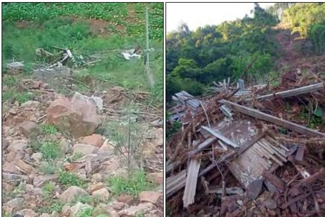
Figura 19. Construções totalmente destruídas por deslizamentos. A esquerda não era habitada e a direita era habitada. Ninguém se feriu.
