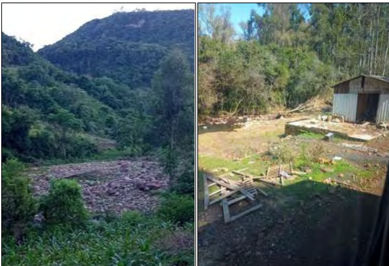
Figura 21. Local onde havia duas residências, sendo uma totalmente destruída e a outra parcialmente.
