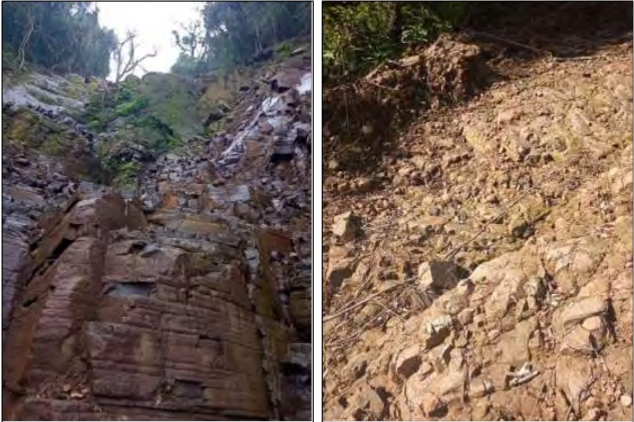
Figura 25. Locais distintos onde ocorreram deslizamentos, restando a rocha-mãe exposta.
