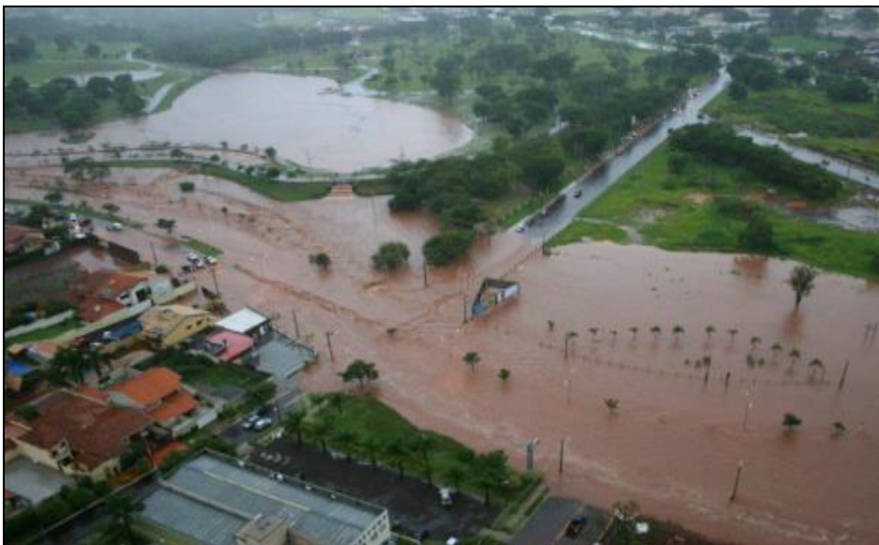
Figura 7: Enchente no Córrego Prosa entre a Avenida Afonso Pena e a Via Parque (2020)
