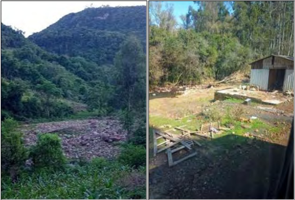
Figura 21. Local onde havia duas residências, sendo uma totalmente destruída e a outra parcialmente.
